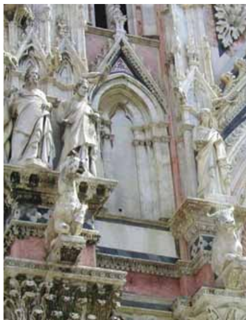
Εικ. 4. Εξωτερικό καθεδρικού του Duomo της Σιένας (Α) Πλάτωνας, (δ) Σίβυλλα, 1284-1296.
